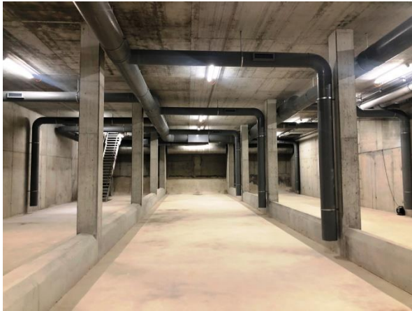
Abb. 1: MWB Jostenmatten, Innenansicht
